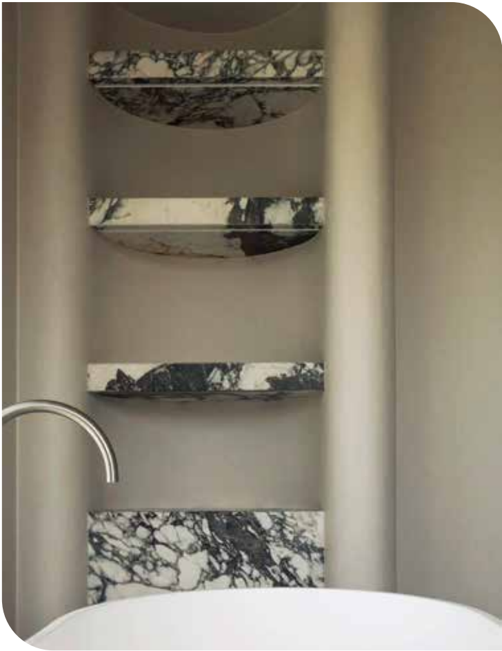
----- Planken op maat gemaakt met calacatta oro-marmer, muurverf Aqua Sensa van Boss Paints met een hot steam schilderstechniek aangebracht. -----
